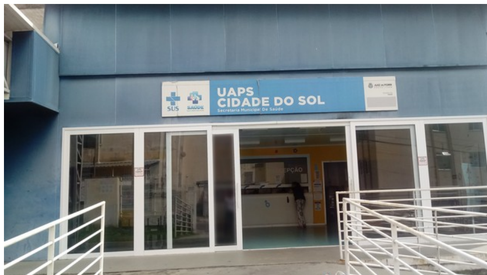
Fachada da Unidade
