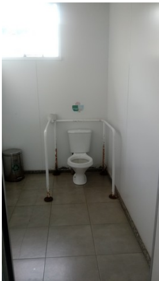
Banheiro masculino dos usuários
