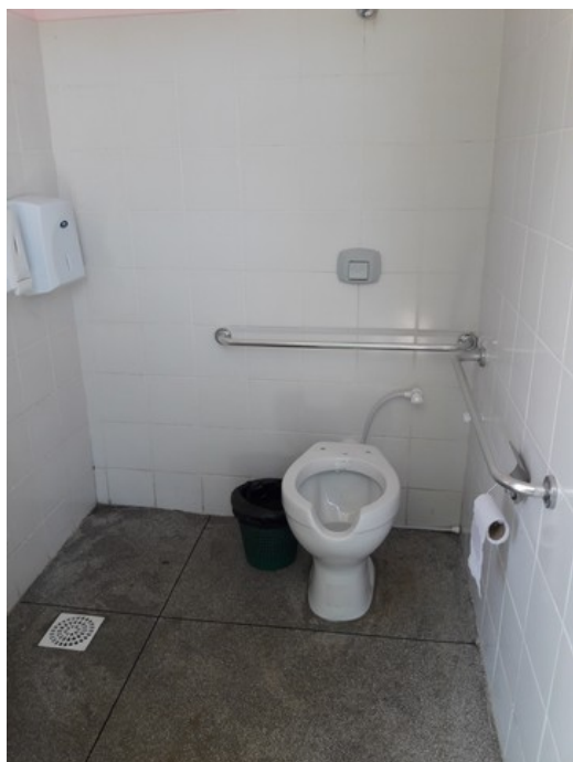
Banheiro adaptado unissex
