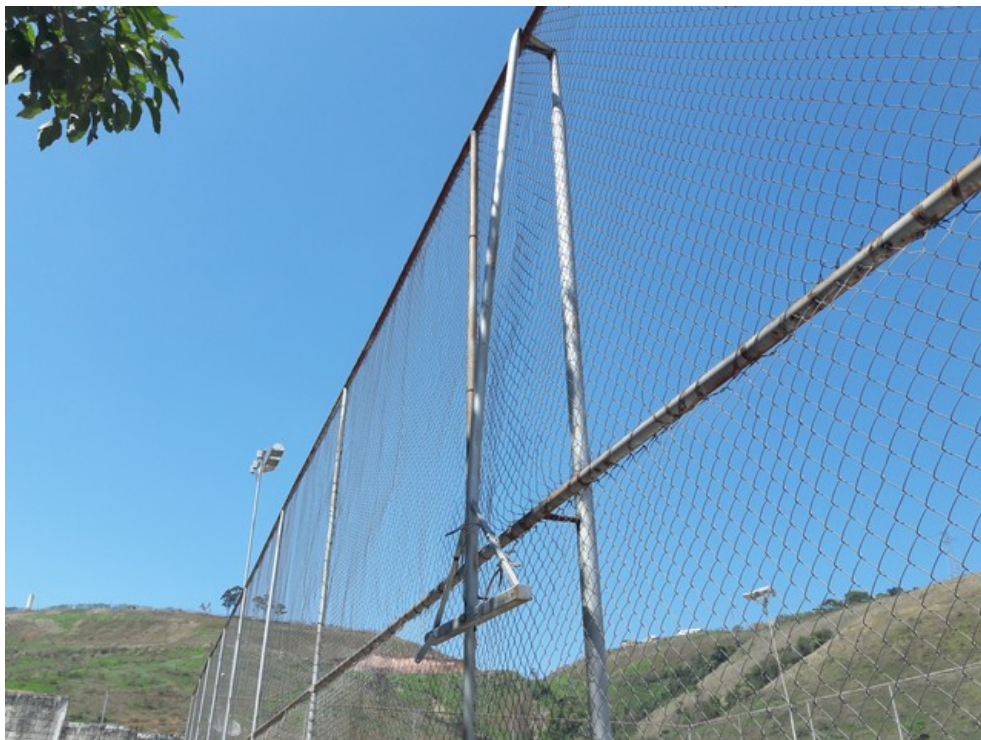
Postes de iluminação da quadra
