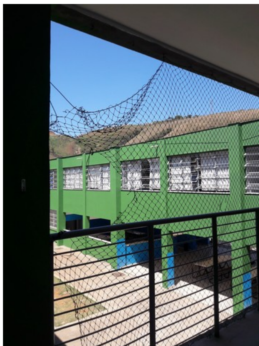
Corredor de acesso às salas (segundo andar)
