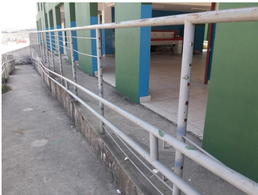
Rampa de acesso à quadra poliesportiva
