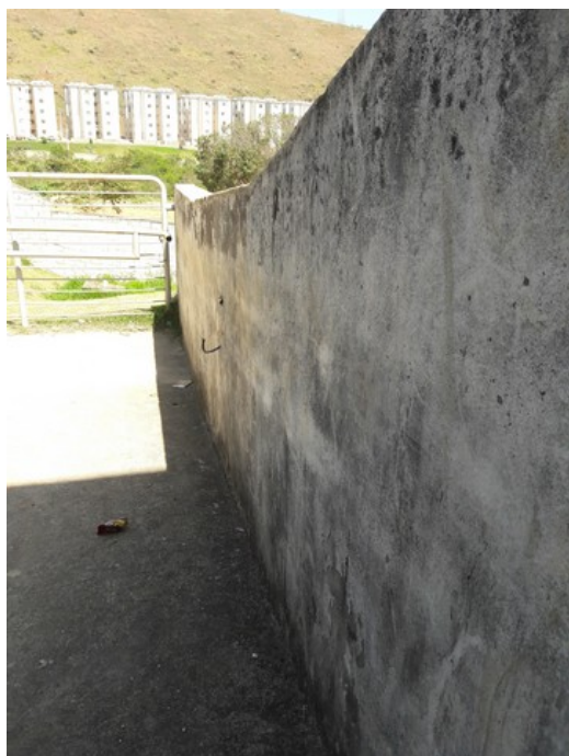
Rampa de acesso à quadra poliesportiva
