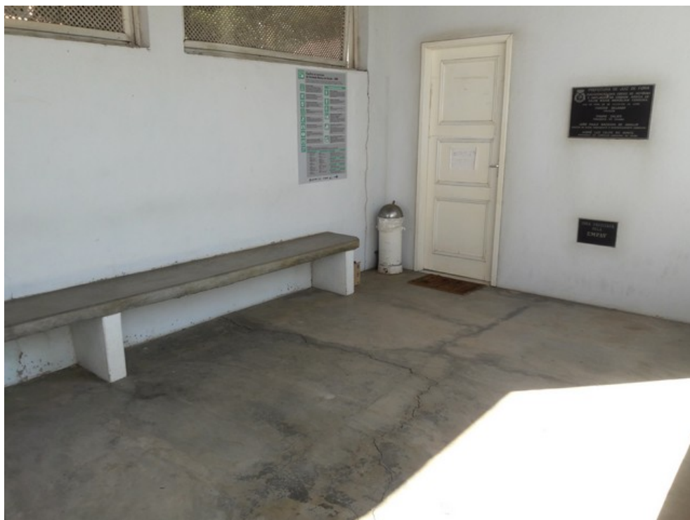
Sala de espera
