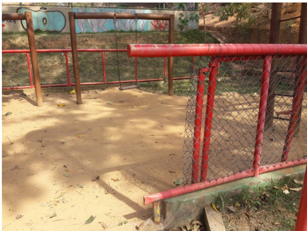
Portão de entrada do parquinho
