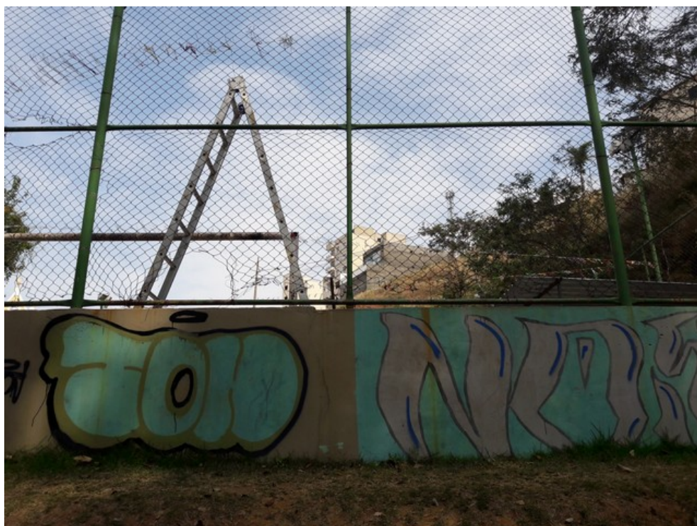
Alambrado da quadra
