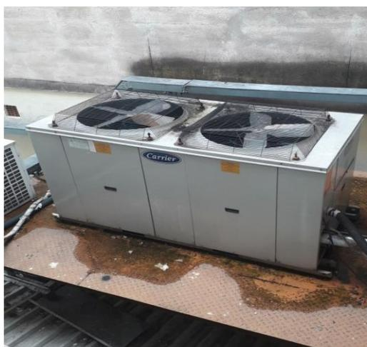
Desmontagem das unidades condensadora e evaporadora do ar condicionado central
